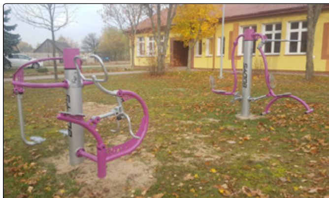
Budowa siłowni zewnętrznej w Małowidzu
