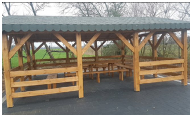
Budowa wiaty rekreacyjno-wypoczynkowej dla sołectwa Drażdzewo Nowe
