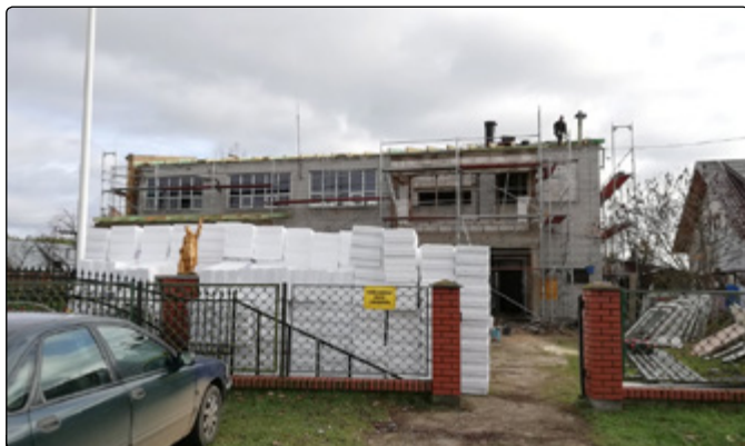
Przebudowa budynku Ochotniczej Straży Pożarnej w Olszewce
